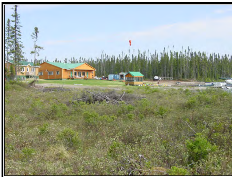
Photo 5. Infrastructures dans l'aire de répartition du caribou forestier (source : AbitibiBowater).
